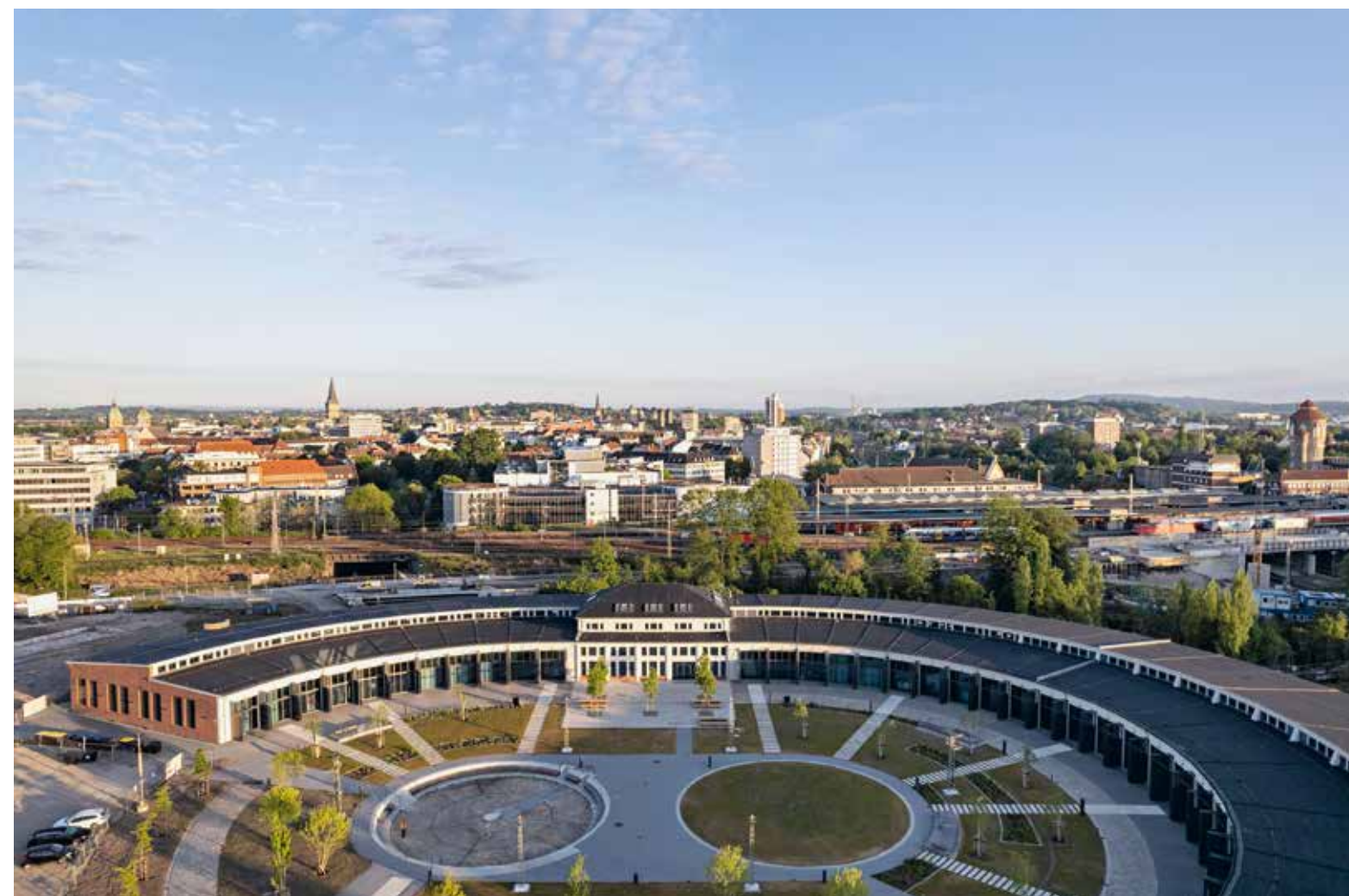
Die ikonische Form eines Lokschuppens: der kreisförmige Grundriss und die stählernen Einfahrtstore der Loks
